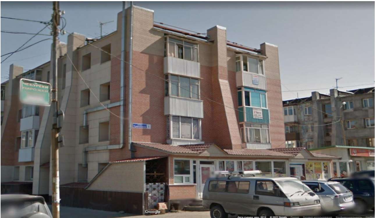
Рис. 5.8. Пример сейсмоусиления многоквартирного дома в г. Петропавловске-Камчатском, ул. Тушканова, 5 1
