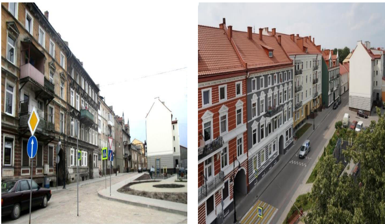
Рис. 5.4. Этапы капитального ремонта МКД в Калининградской области, г. Черняховск, ул. Театральная, 10–20
