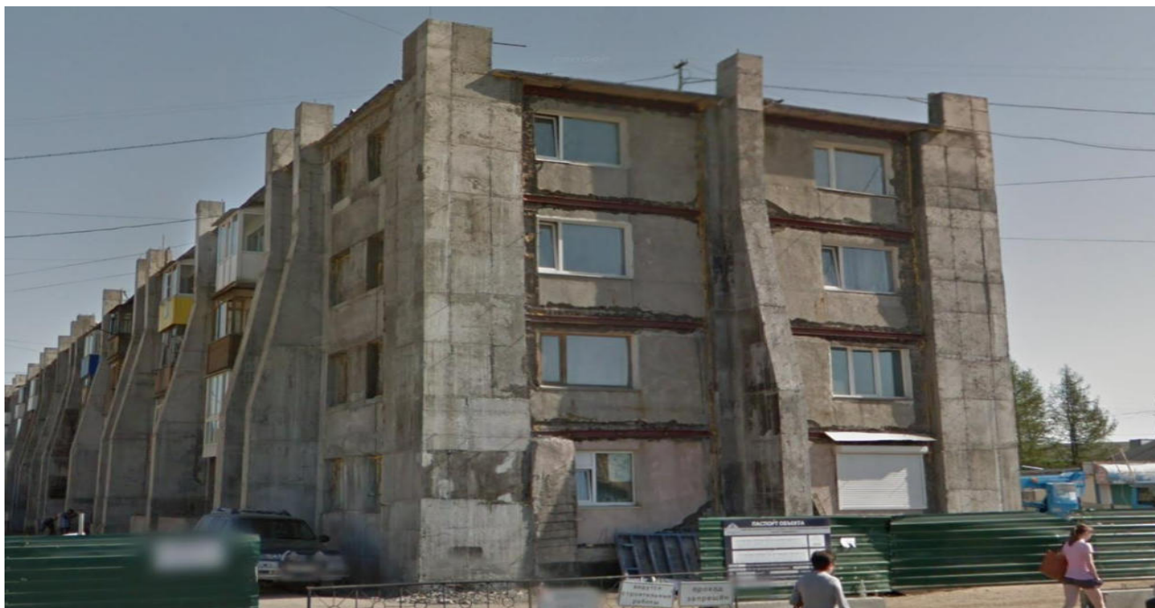
Рис. 5.7. Процесс сейсмоусиления многоквартирного дома в г. Петропавловске-Камчатском, ул. Тушканова, 3
