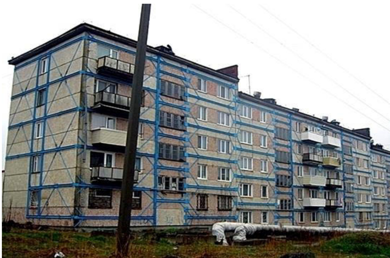
Рис. 5.9. Пример сейсмоусиления многоквартирного дома в г. Советская Гавань
