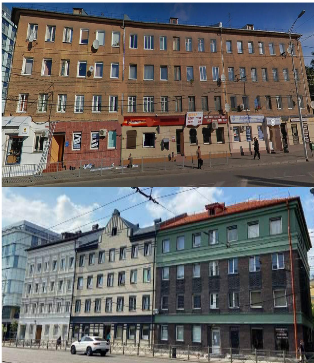
Рис. 5.5. Реконструкция в рамках капитального объекта по адресам г. Калининград, ул. Черняховского, 1–5
