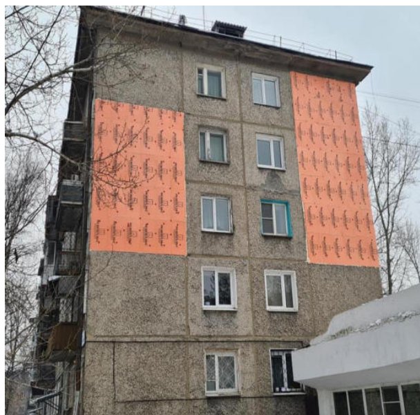
Рис. 5.12. Разрушения торцевой наружной стеновой панели дома серии 1-335, г. Иркутск, ул. Депутатская, 110, 2018–2019 гг.: 1 — состояние фасадной плиты здания на момент обследования МКД (апрель — май 2018 г.), внешние признаки разрушения незначительны; 2 — состояние фасадной плиты после обрушения (май 2019 г.) и ремонта теплоизоляции наружного ограждения объекта (ноябрь 2019 г.)
