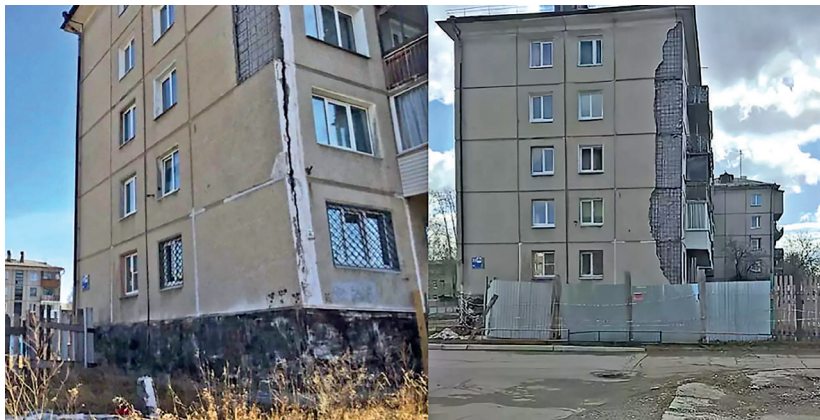
Рис. 2.4. Обрушение торцевой стены в жилом доме в г. Ангарске в 2018 г.
