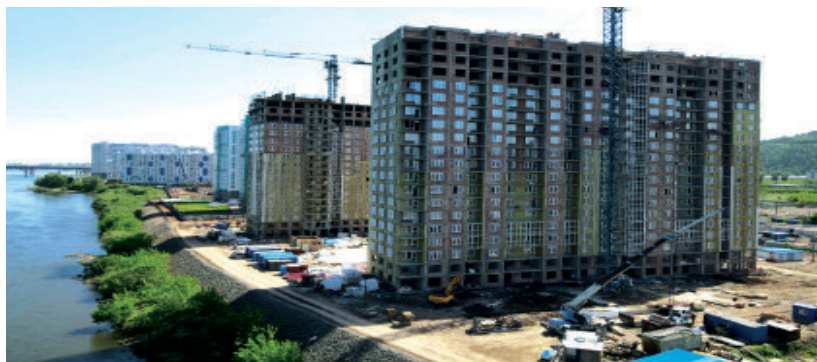
Рис. 8.6. Строительство ЖК «Тихие зори»
