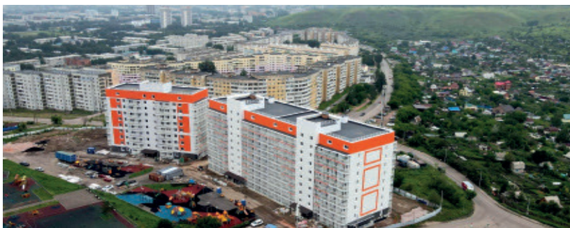
Рис. 8.9. Строительство ЖК «Новые Черемушки»
