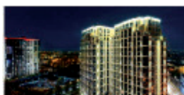
«Стрижи Сити», г. Иркутск
