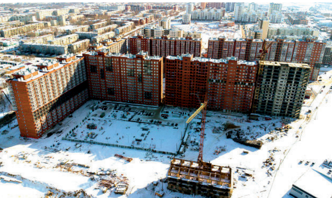
Рис. 8.25. Процесс строительства ЖК «Мега» (8-й мкр-н)
